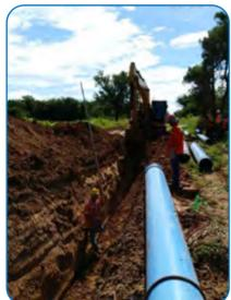
Au total, plus de 172 km de tuyaux en PVC-BO TOM® et plus de 200 accessoires ecoFITTOM® ont été installés, notamment des coudes 45 °C, des coudes 22,5 °C, des manchons et des réductions de tous les diamètres fabriqués par Molecor.
