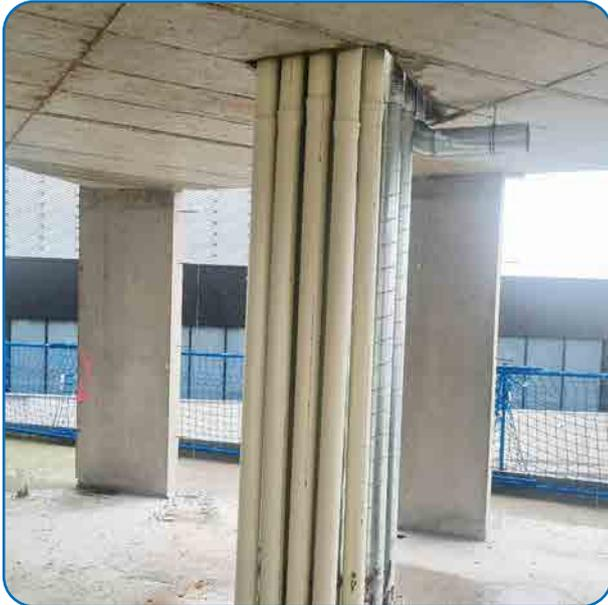
El **Sistema de evacuación insonorizado AR**®, fabricado en PVC y aditivado contra el fuego, no produce llama y por tanto no existe riesgo de que propague un incendio.
