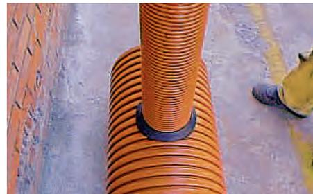
Opcionalmente, antes de introducir el tubo, se puede colocar una pieza tope en forma de diadema que sirva para que la tubería no pase más de lo necesario hacia el interior del colector o del pozo.
