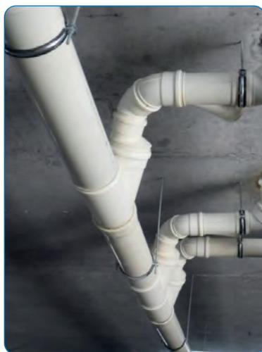
O **sistema de evacuação insonorizada AR®** permite a construção de estruturas silenciosas para projetos de edificação. O **PVC de três camadas** que compõe esta gama tem vantagens exclusivas que, entre outras, incluem a redução dos níveis de ruído e a melhor proteção possível contra o fogo que um plástico pode alcançar.
