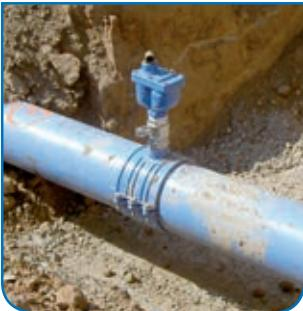
A abraçadeira de ramal deve ficar perfeitamente solidária à tubagem. Não se devem utilizar abraçadeiras multidiâmetros, senão abraçadeiras para tubagens PVC com diâmetros específicos para cada DN.
