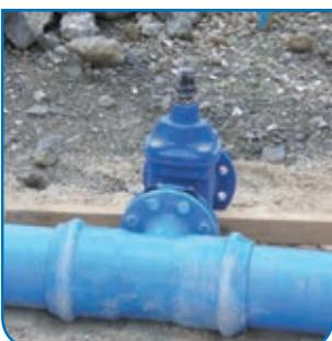
Com o fim de garantir a resistência estrutural da rede, é imprescindível e fundamental a fixação do acessório ao terreno.
