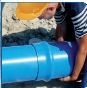
Dar um empurrao firme e seco com o tubo cujo cabo vai ser introduzido na embocadura para desta forma aproveitar a inércia do tubo. Introduzir o cabo até que a marca fique oculta.
