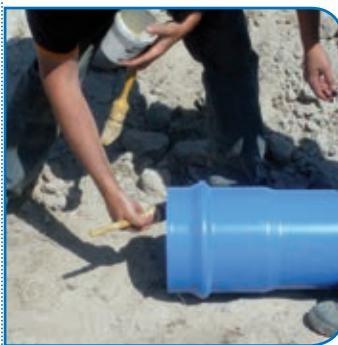
Aplicar lubrificante no bisel do cabo e na junta da embocadura.
