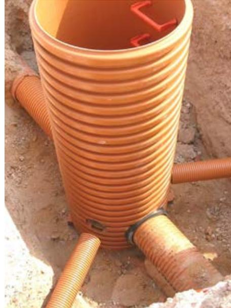
O corpo do poço SANECOR® é fabricado a partir de tubo SANECOR® SN8
