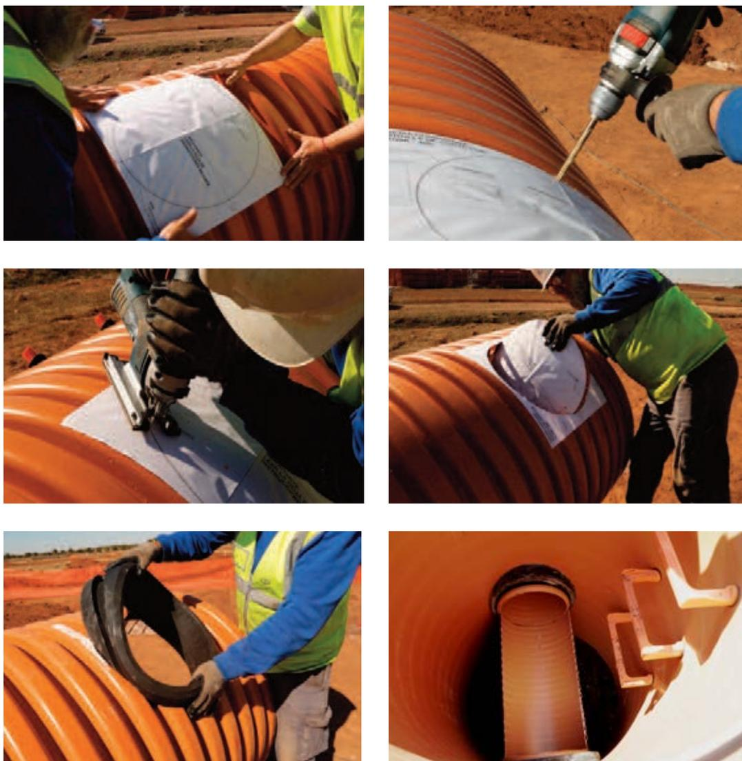
Sequência de instalação de um clipe elastomérico
