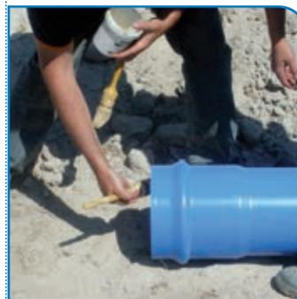
Appliquer le gel lubrifiant sur le chanfrein de l'extrémité mâle et sur le joint de l'emboîture.
