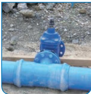
Il est indispensable de réaliser l'ancrage au sol des raccords.
