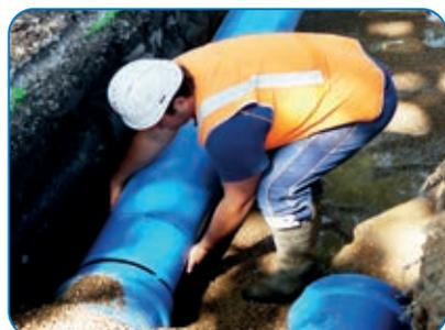
La longueur de limite d'emboîture est la distance entre l'extrémité biseautée du tuyau et la marque repère imprimée.
