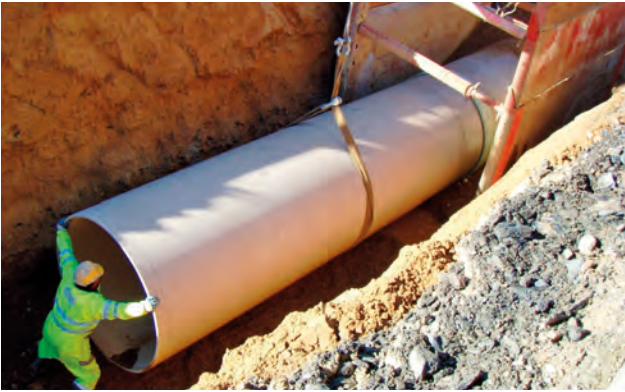
MONTAJE DE TUBOS DE PRFV EN ZANJA ENTIBADA.
