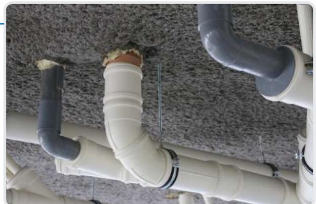
La **ventilation secondaire doit être installée dans les bâtiments où la ventilation primaire n'est pas suffisante**, c'est-à-dire ceux qui dépassent 11 étages ou ceux de plus de 7 étages dont la descente n'est pas surdimensionnée et dont les conduits mesurent plus de 5 mètres.
