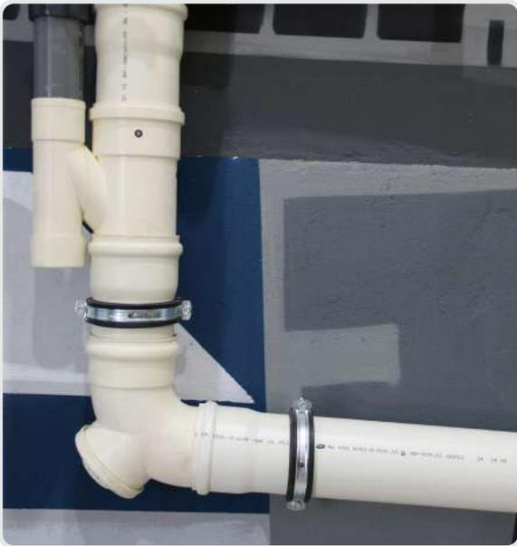
Cela consiste en l'installation d'un tuyau parallèlement au tuyau de descente connecté avec celui-ci, de façon à prévenir le développement de dépressions excessives, en particulier dans la partie inférieure de la descente, permettant à l'air comprimé à la base de la colonne de trouver une sortie.
