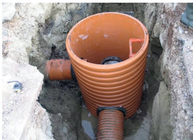
Ejecución de acometidas realizadas in situ
