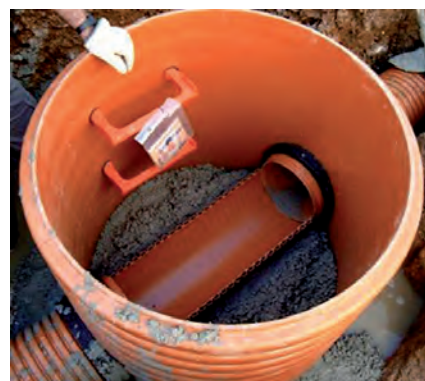
Acabado interior de un pozo a 180°
