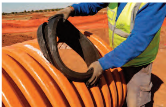
Secuencia de instalación de un clip elastomérico
