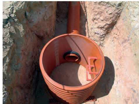
Acabado del fondo del pozo rematado con hormigón (Solamente recomendable sin freático)
