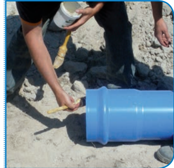
Appliquer le gel lubrifiant sur le chanfrein de l'extrémité mâle et sur le joint de l'emboîture.
