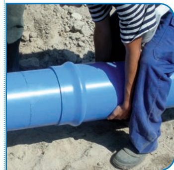
Aligner les tubes et introduire le chanfrein dans l'entrée de la tulipe.
