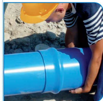
Exercer une poussée sur l'extrémité mâle pour l'introduire dans la tulipe jusqu'à la marque.
