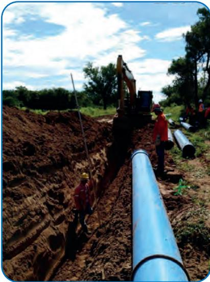
Au total, plus de 172 km de tuyaux en **PVC-BO TOM®** et plus de 200 **accessoires ecoFIT TOM®** ont été installés, notamment des coudes 45 °C, des coudes 22,5 °C, des manchons et des réductions de tous les diamètres fabriqués par **Molecor**.
